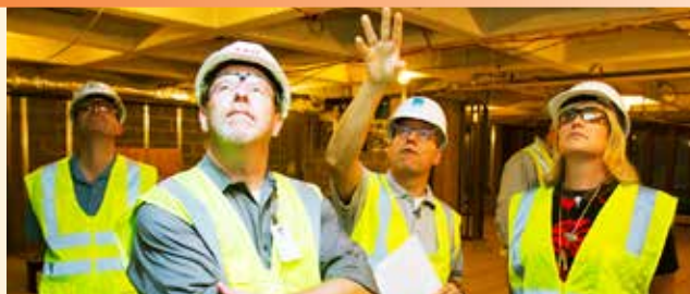
HQ1修繕工事の進捗を検査するカルラ・グラスコ副専務理事(右)
