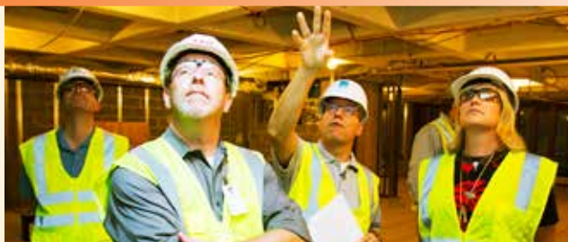
Carla Grasso, Directrice générale adjointe (à droite), inspecte le chantier de rénovation de HQ1.
