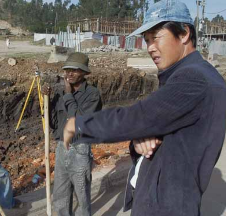
عامل بناء صيني يشرف على إنشاء طريق في إثيوبيا
