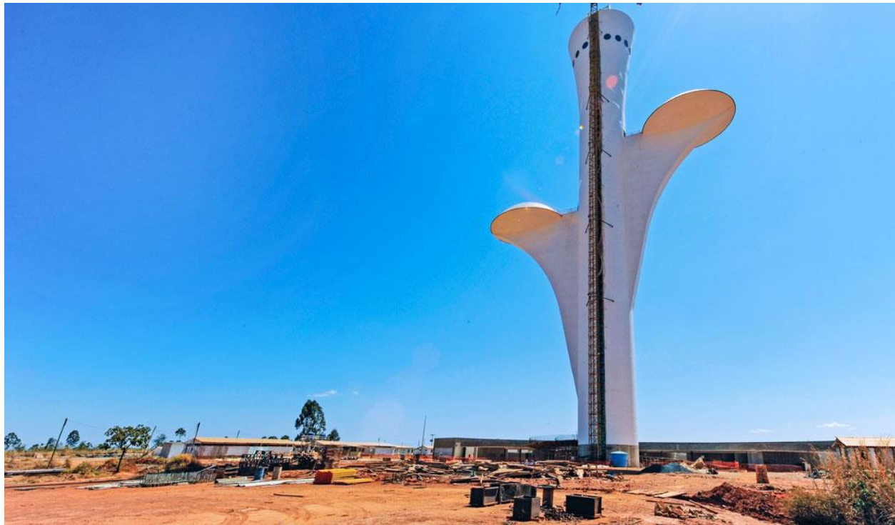
Construção de torre de TV digital em Brasília, Brasil (foto: Wagner Santos/Avalon/Newscom)
