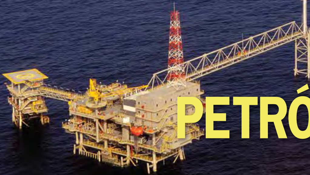
Plataforma de perforación en la costa de África occidental.
