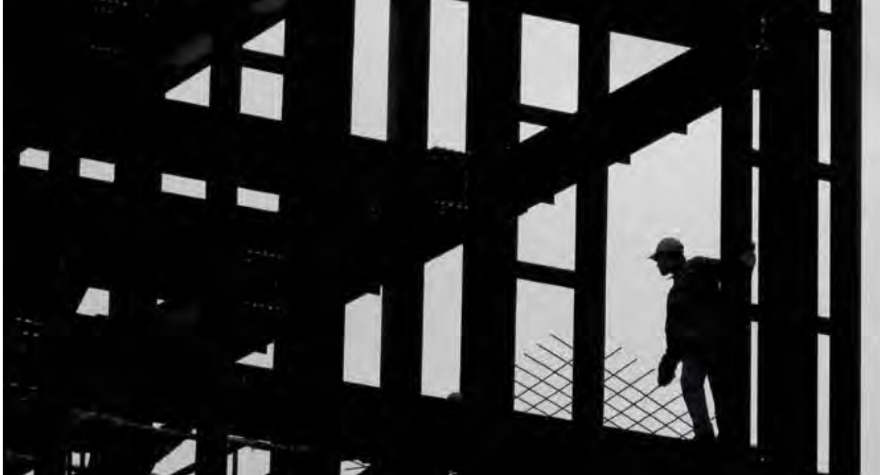
Un obrero, en un edificio en construcción en Atenas, Grecia.
