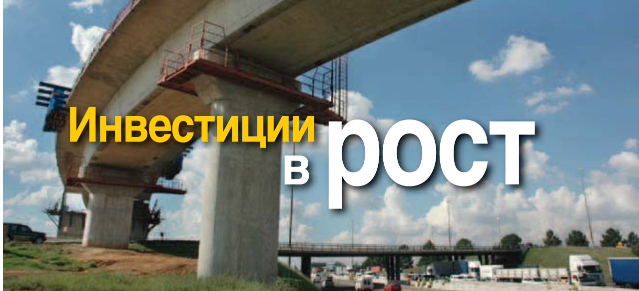
Строительство развязки на автомагистрали в Йоханнесбурге, Южная Африка.
