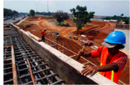
印度尼西亚雅加达的道路建设。基金组织的新工作计划旨在支持全球经济增长和合作(照片: Crack Palinggi/Newscom)
