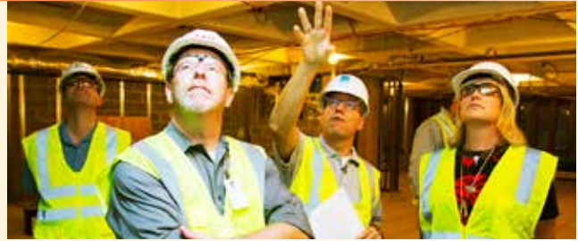
Die Stellvertretende Geschäftsführende Direktorin Carla Grasso (rechts) begutachtet die Fortschritte bei der Renovierung von HQ1.
