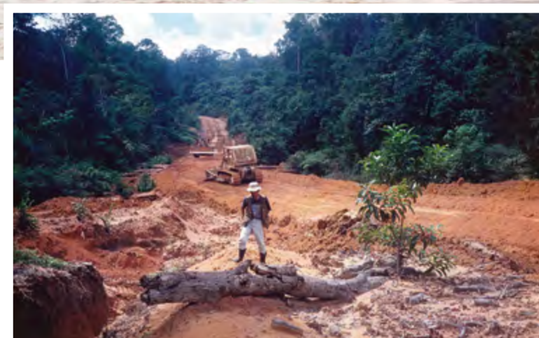
人们用推土机清理印度尼西亚加里曼丹丛林腹地的一条新建的道路。
