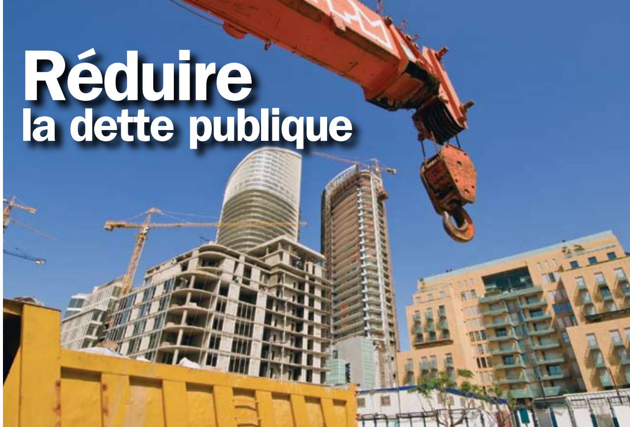
Chantier à Beyrouth.
