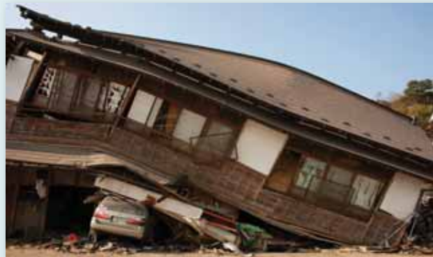
Dégâts provoqués par le tsunami au Japon en mars 2011.
