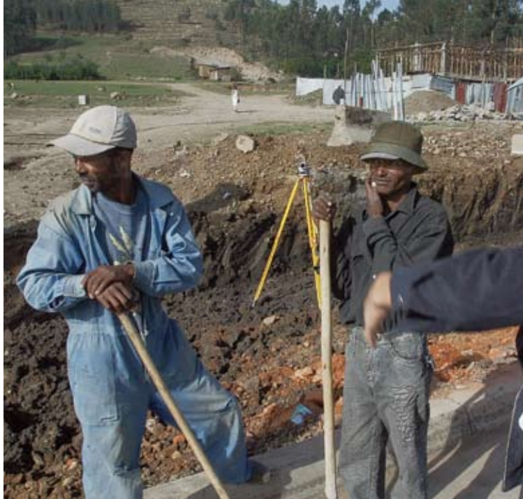
Un trabajador chino supervisa la construcción de una carretera en Etiopía.
