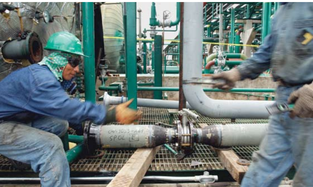
Modernización de una plataforma petrolera ecuatoriana.
