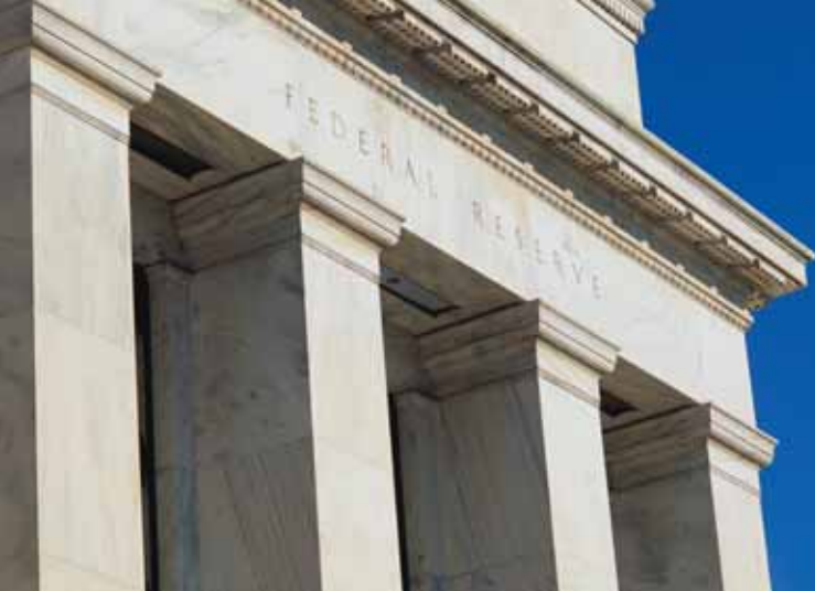
Edificio de la Reserva Federal de Estados Unidos en Washington.
