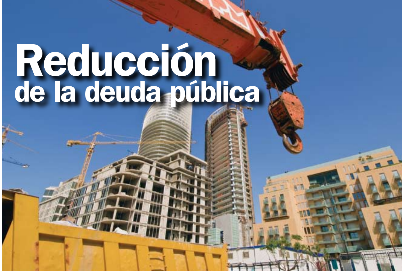
Construcción en Beirut.
