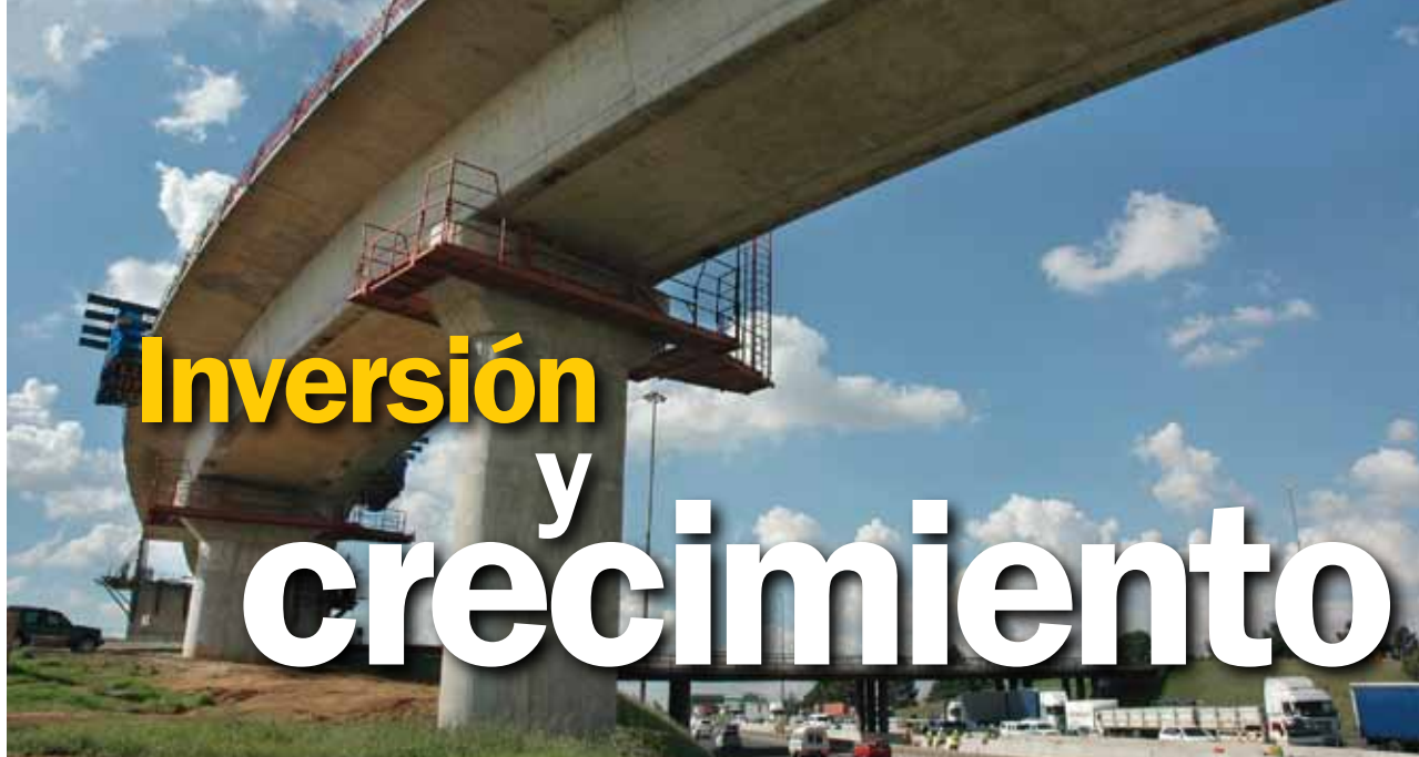
Autopista en construcción en Johannesburgo, Sudáfrica.
