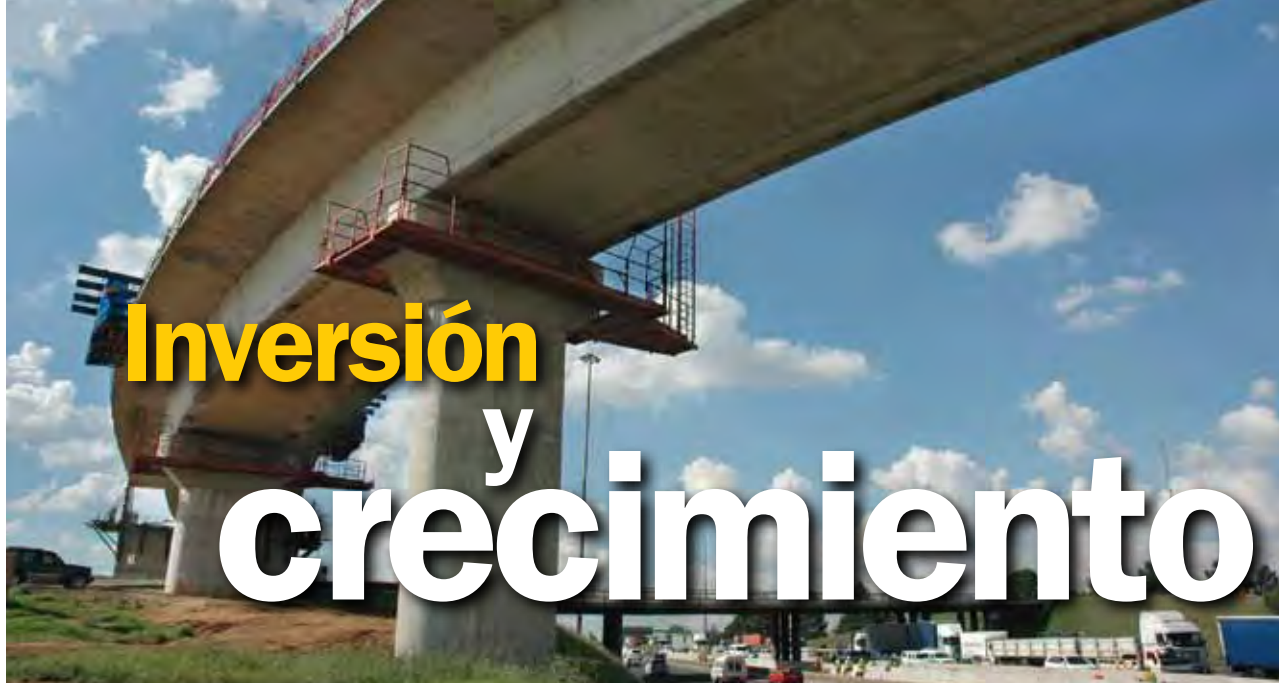
Autopista en construcción en Johannesburgo, Sudáfrica.
