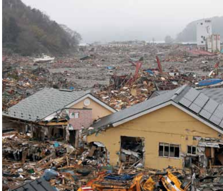
Destrucción en Japón después del terremoto y tsunami de marzo de 2011.
