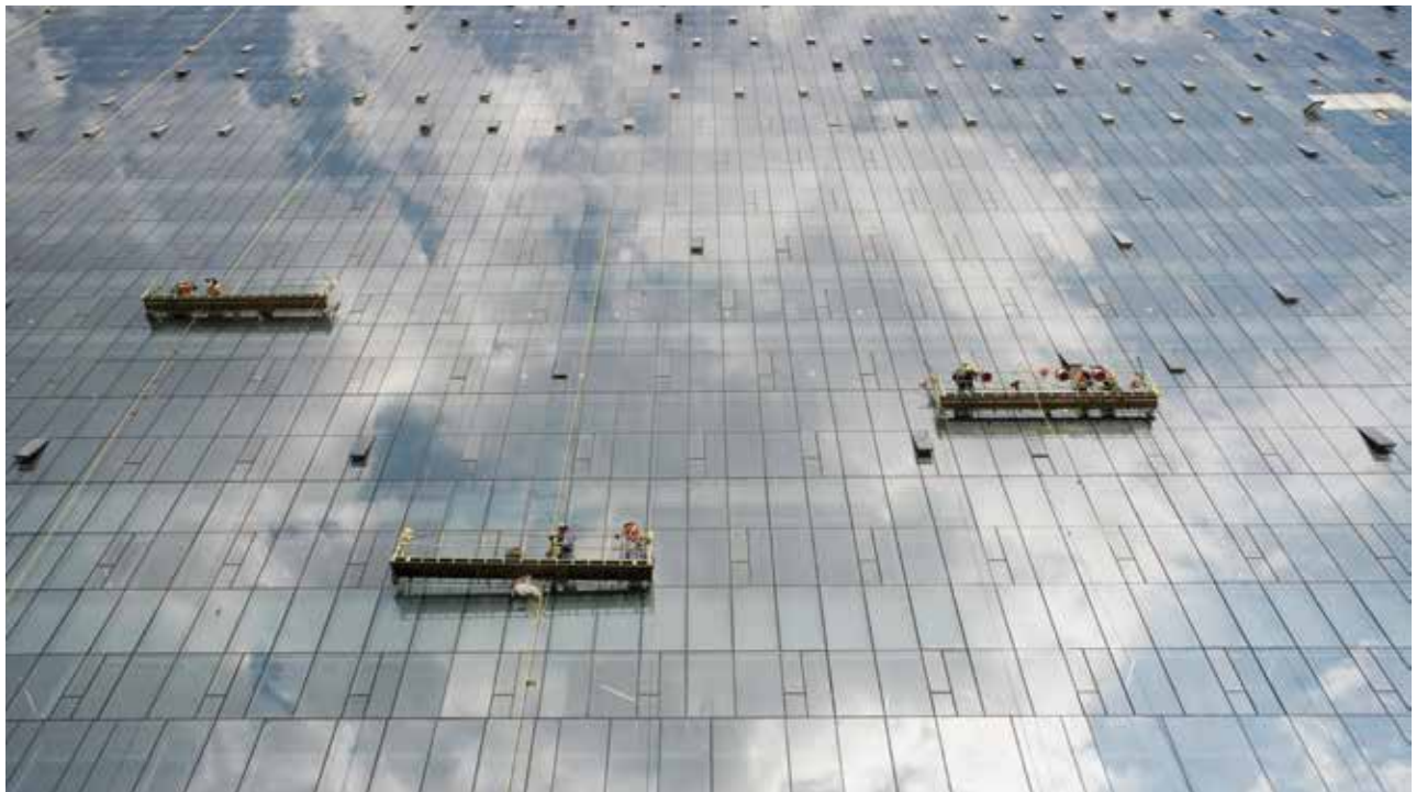
Construcción del Museo Soumaya, Ciudad de México, México.
