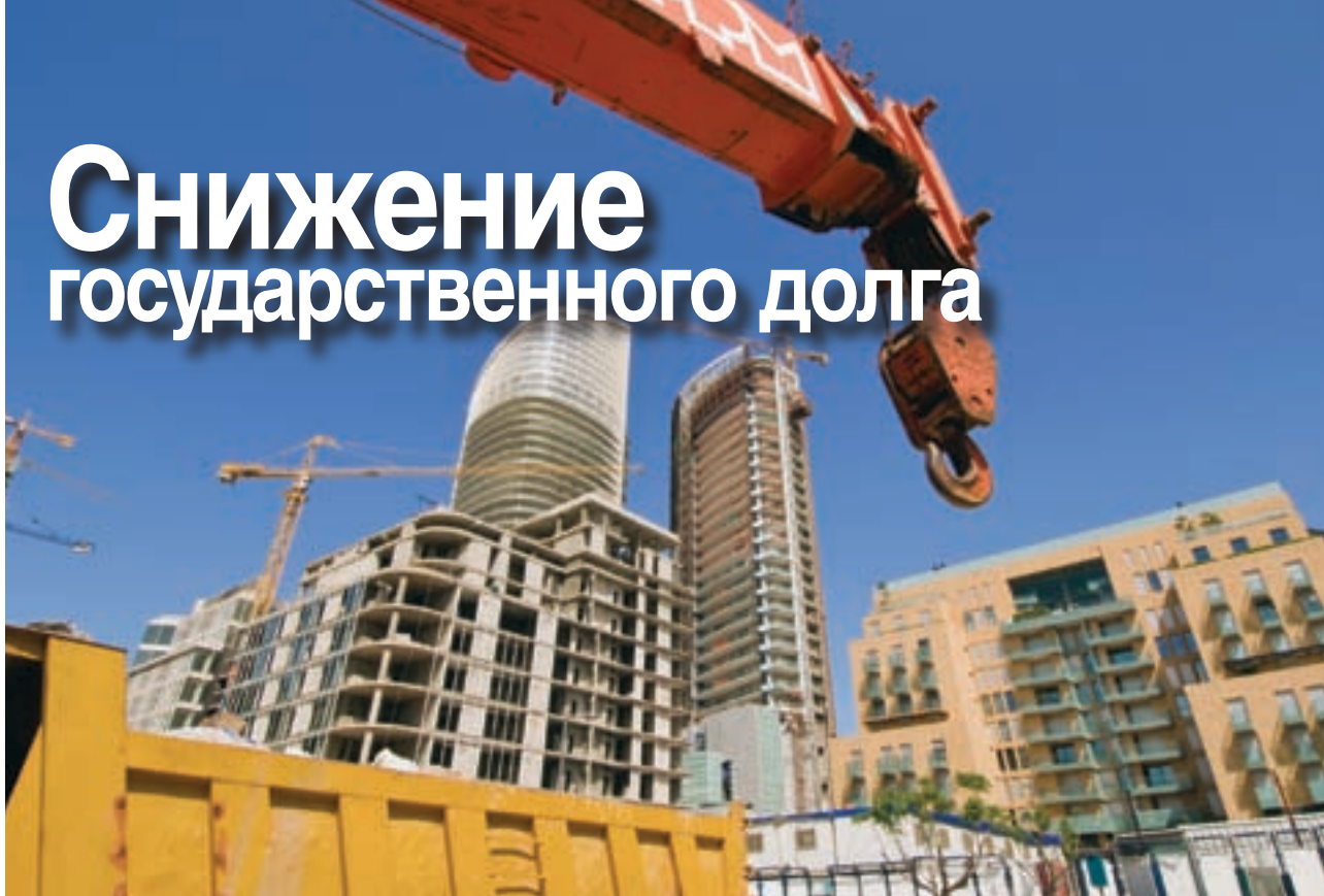
Строительство в Бейруте.
