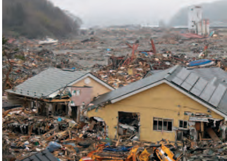
Разрушения в Японии после землетрясения и цунами 2011 года.
