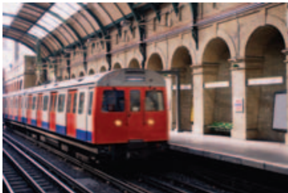
Станция метро Notting Hill Gate, Лондон, Англия.
