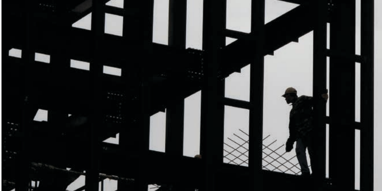
Рабочий на строительстве здания в Афинах (Греция).
